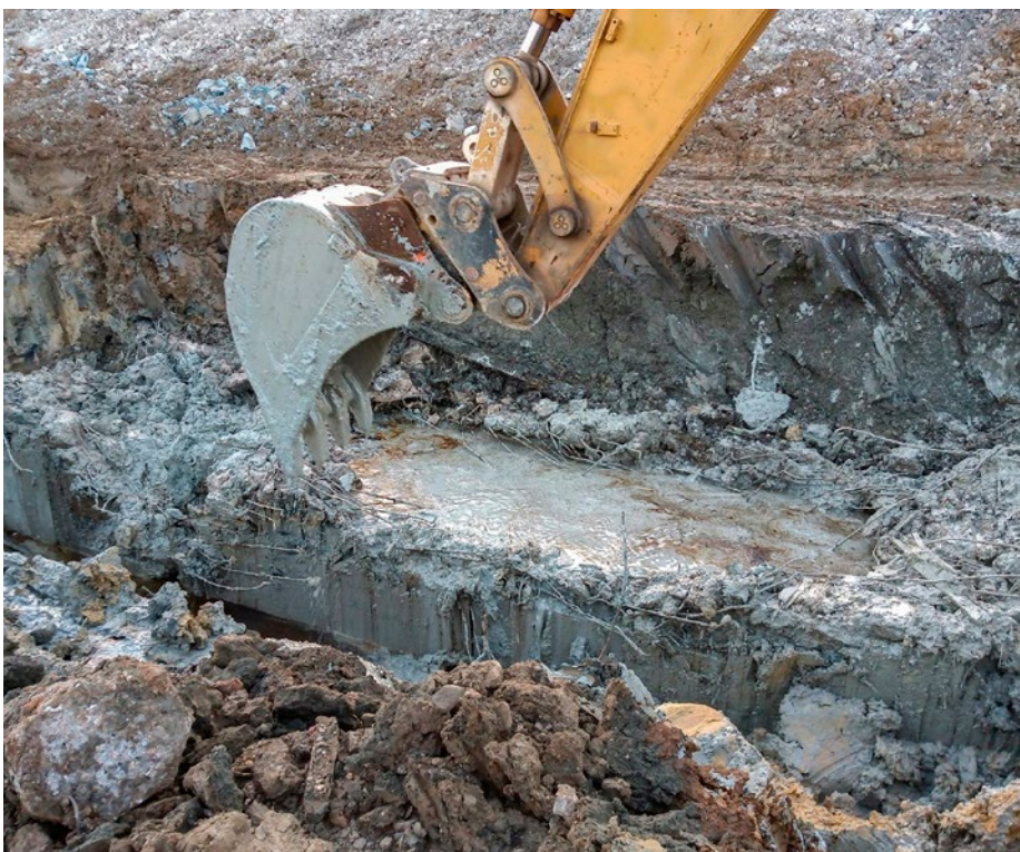
Figure 1 : Découverte d'une fosse en béton - ©DR – photo Brézillon
