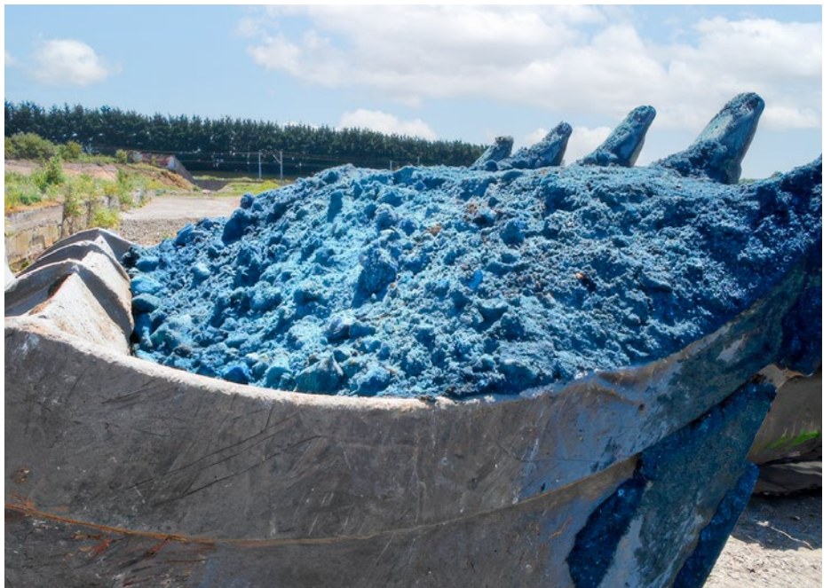
Figure 8 : Excavation des terres impactées par des cyanures avec des colorations bleues
