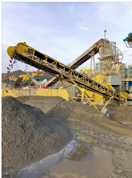
Figure 3 : le traitement sur site par lavage des sols permet une large revalorisation des matériaux en remblayage.
