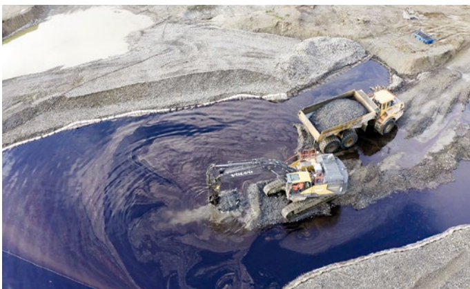
Figure 1 : Excavation des sols et écrémage des surnageants
