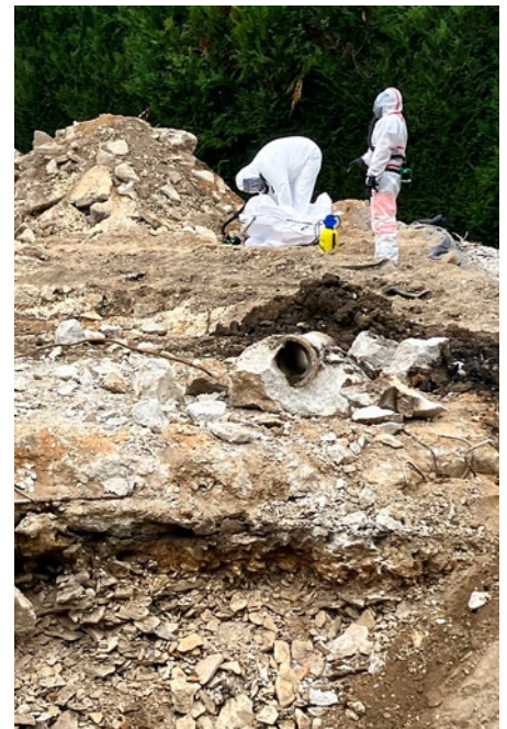
Figure 3 : Ramassage de canalisation amiantée en SS4
