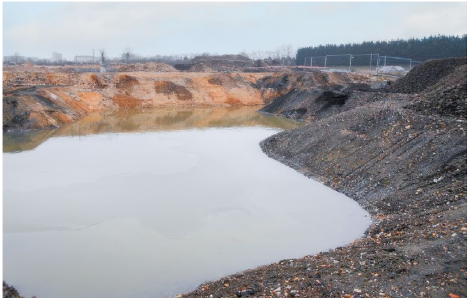
Figure 7 : Zone des terres polluées aux hydrocarbures après excavation
