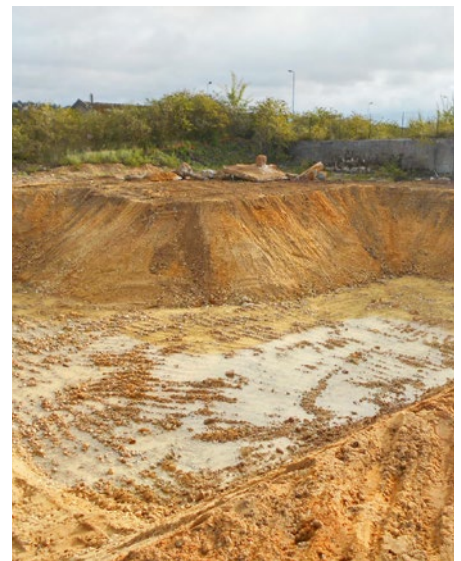
Figure 6 : Zone excavée et apport de calcaire filler
