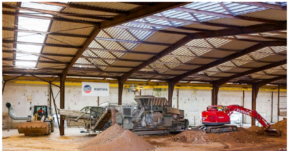
Figure 1 : Travaux sous tente
