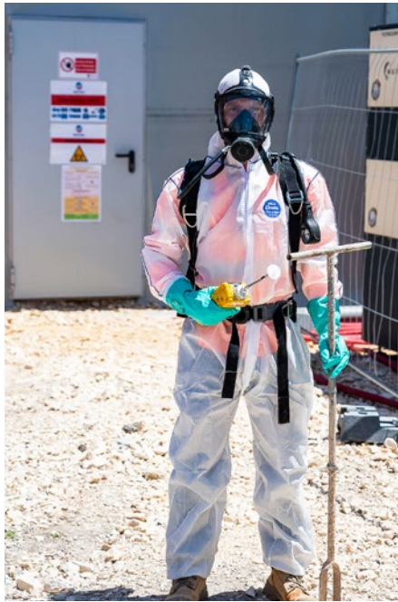
Figure 2 : Intervention sous tente en ARI - mesures et contrôles des travaux
