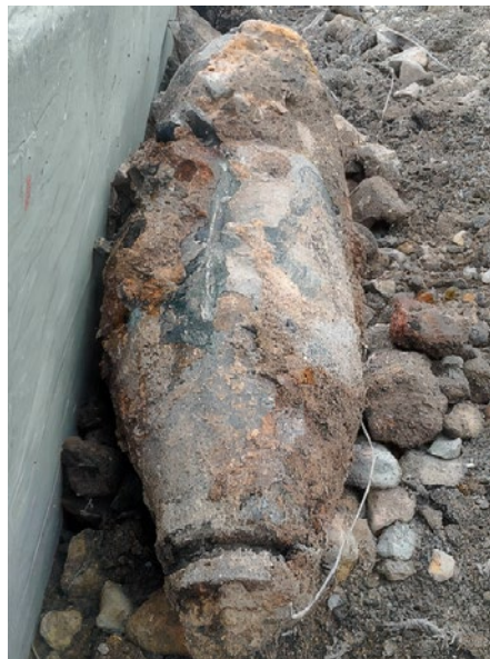
Figure 1 : découverte d'une bombe d'aviation dans les remblais du site : intervention de la Sécurité Civile
