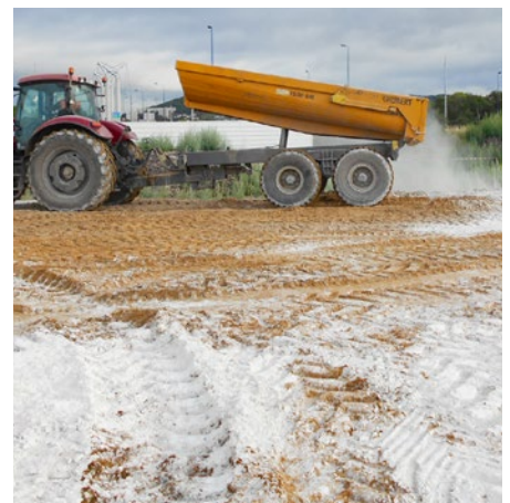
Figure 6 : Zone excavée et apport de calcaire filler
