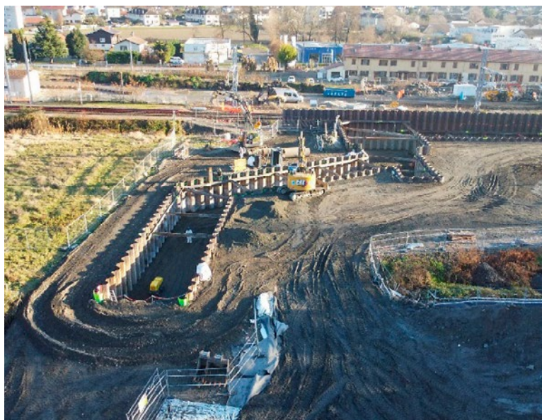
Figure 4 : Emprise de chantier, avec contraintes de place et de gestion des flux
