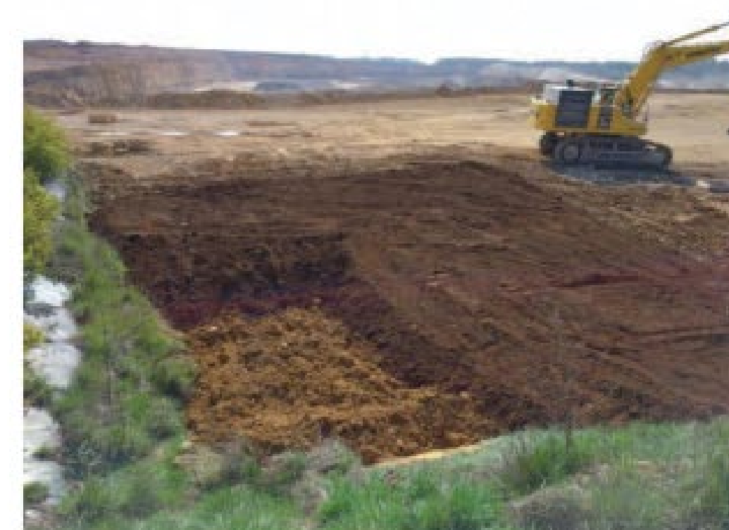
Cogesud Bainville - restauration de carrière après comblement
