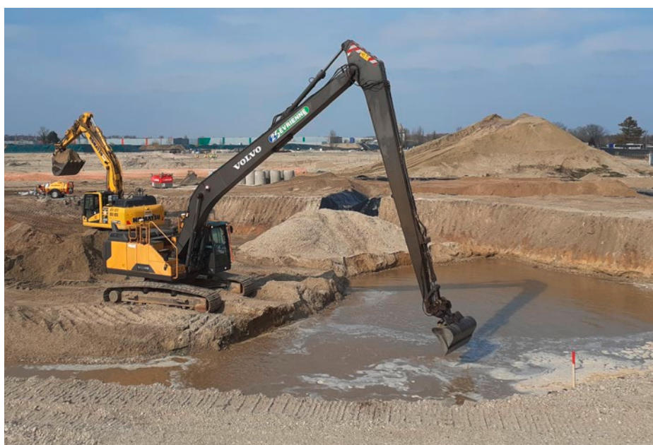
Figure 4 : Excavation à la pelle long bras avec guidage GPS
