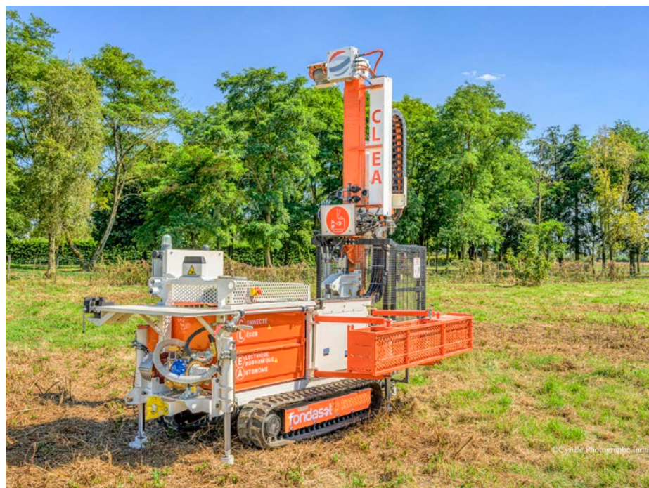
Figure 1 : CLEA atelier de forage 100 % électrique
