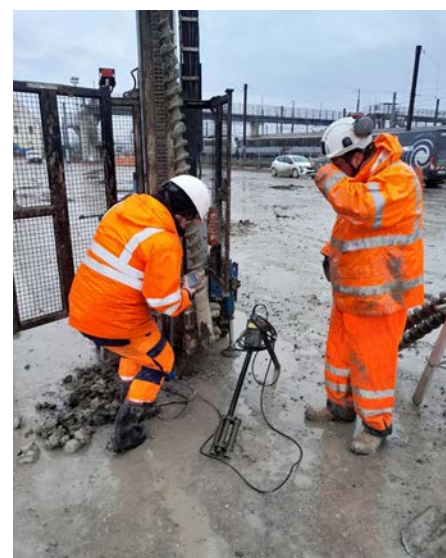
Fig 4 : Opérateur en dépollution pyrotechnique réalisant une mesure à l'aide d'un magnétomètre borehole
