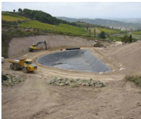
Fig. 8 : Création d'un bassin de stockage de lixiviats, et foration d'un puits biogaz
