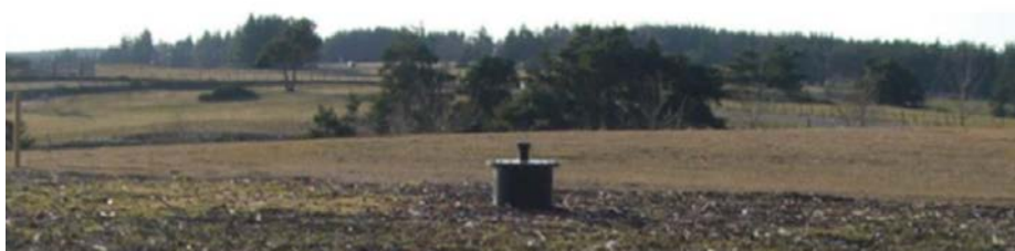
Fig. 9 : Dégazage passif par biofiltre
