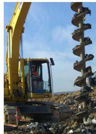
Fig. 8 : Création d'un bassin de stockage de lixiviats, et foration d'un puits biogaz
