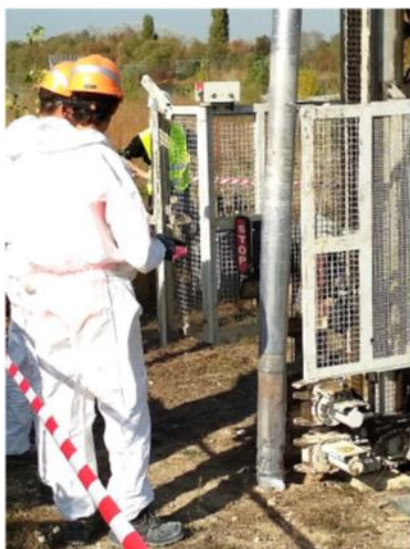
Figure 12 : Exemple de sondage réalisé au carottier Sonique (à gauche) - Ensachage de la carotte (à droite et en bas).
