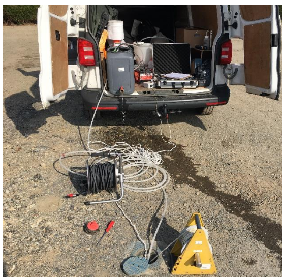
Figure 29 : Traitement des eaux sur site par filtre à sable puis filtre à charbon (source BRGM).
