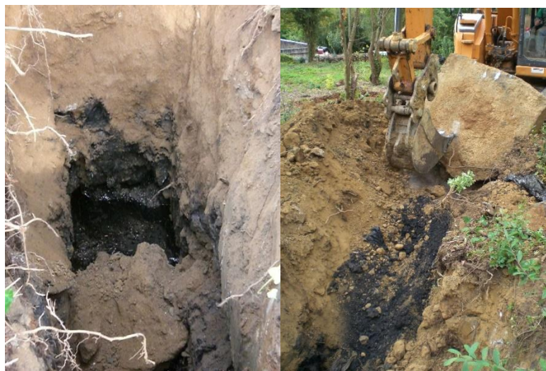
Figure 13 : Exemples de tranchées réalisées à la pelle mécanique.
