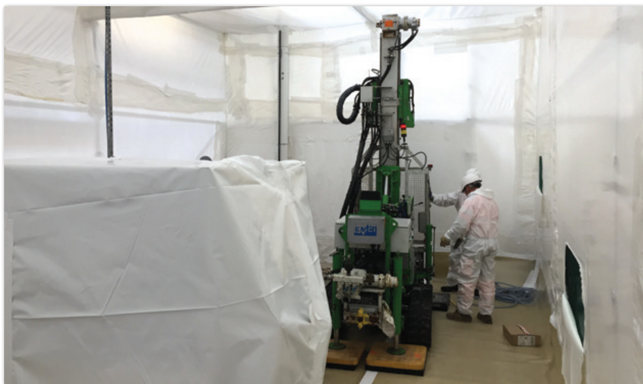
Atelier de forage dans une des zones de confinement
