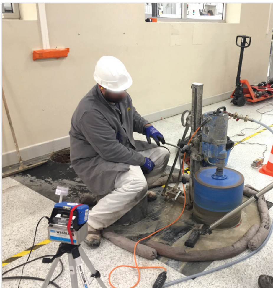
Opération intrusive avec suivi d'empoussièrement et vibrations
