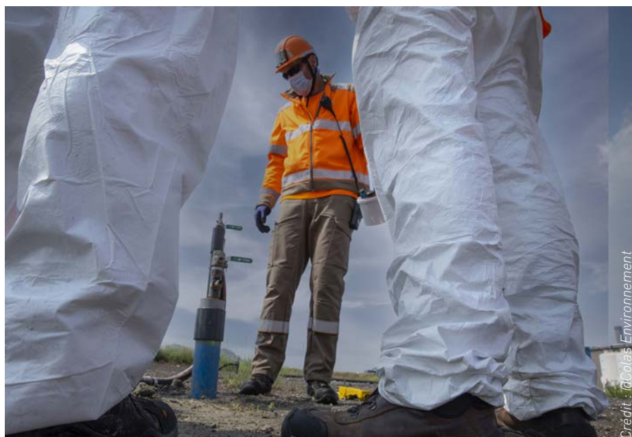
Observation d'un ouvrage de contrôle d'extraction sous vide
