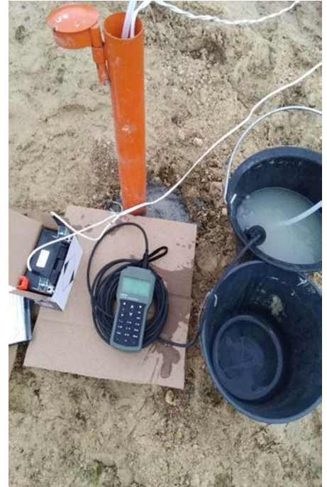
Figure 2 - Prélèvement d'eaux souterraines
