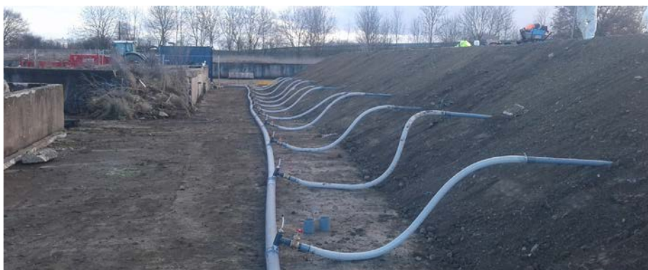
Figures 3 et 4 : Traitement des terres excavées
