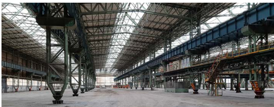
Figure 6 : Site prêt à accueillir de nouvelles installations
