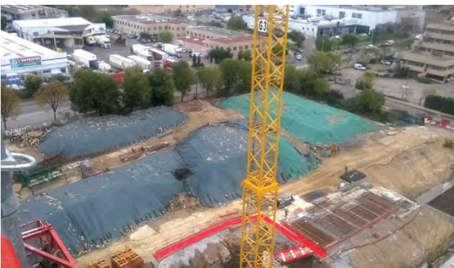
Aires de stockage temporaires
