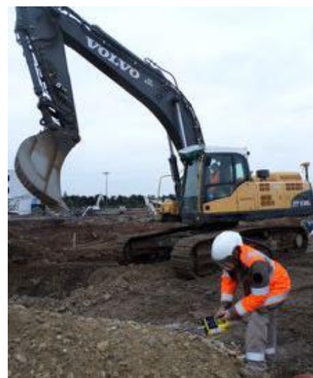
Terrassement de terres impactées aux COVs et gestion de cuves enterrées
