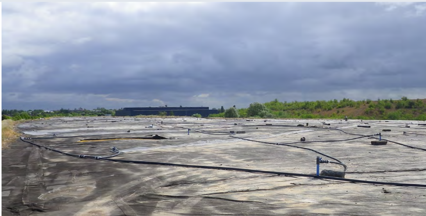
Figure 3 : réseau d'injection au toit du terril.
