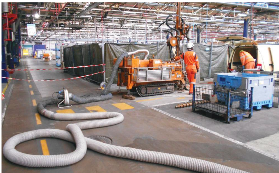
Figure 1 : Sondage MIP à l'intérieur d'un bâtiment.
