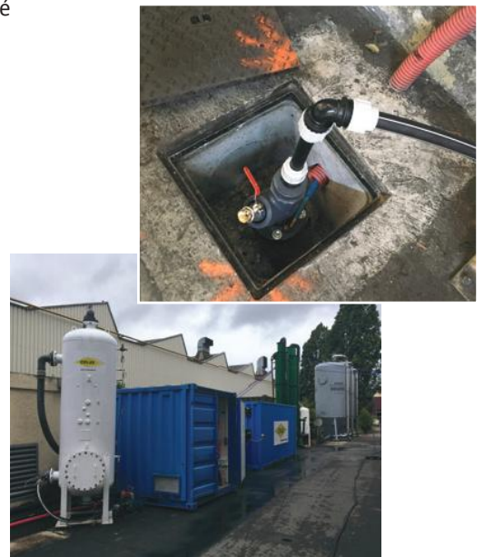
Figure 3 : Système d'extraction multi-phases et unités de traitement.
