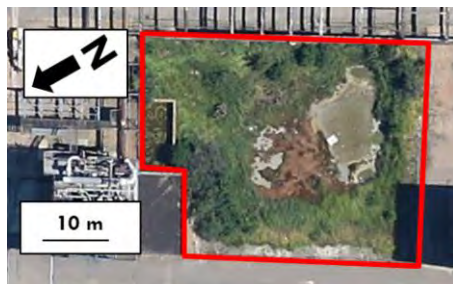
Figure 83 : Vue aérienne du site (Colombano et al., 2012)
