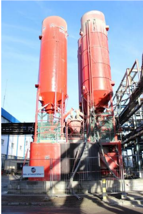
Fabrication du coulis / de la solution
