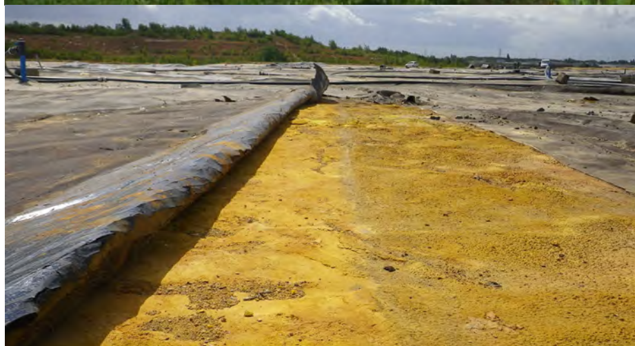
Figures 1 et 2 : vue d'ensemble du Grand Terril de Chrome PCUK à Wattrelos (en haut) ; Ouverture de la géomembrane et réalisation d'une tranchée dans les résidus chargés en Cr VI .
